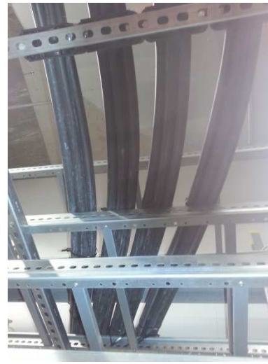
Power & PE cables
